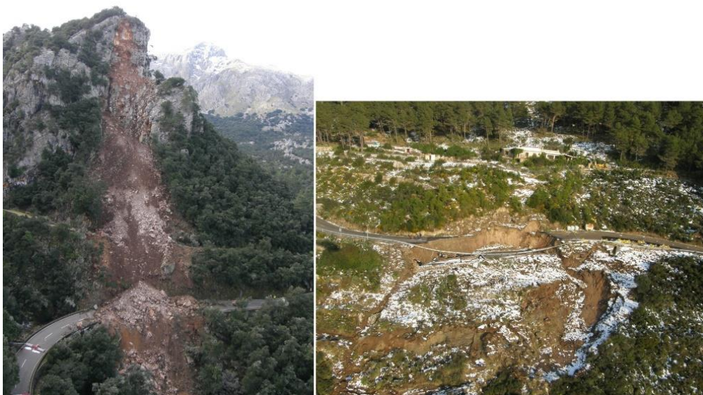
Fig. 5. Cortes de la carretera Ma-10 en Mallorca durante los años 2008-2010, la principal vía de comunicación de la Serra de Tramuntana. Izquierda: Desprendimiento rocoso de Sa Calobra (diciembre 2008); derecho: deslizamiento de Estellencs (marzo 2010).
