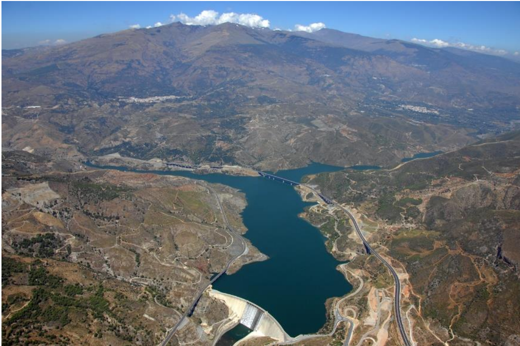
Fig. 8. Presa de Rules (Granada) sobre el río Guadalfeo. La retención de sedimento está causando un retroceso progresivo de la línea de costa granadina y del delta de Salobreña, aguas abajo del embalse
