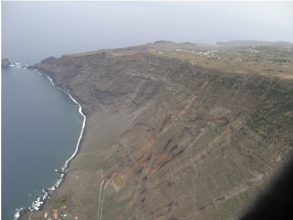
Fig. 13. Ladera de Frontera, con casi 1000 m de altura, y boca del túnel de los Roquillos. La ladera sufrió continuos desprendimientos de roca por la sismicidad inducida de la erupción volcánica
